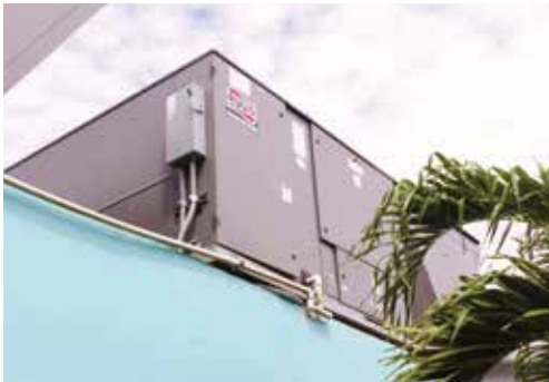
Los problemas de climatización se han corregido con nuevas unidades de aire acondicionado.
